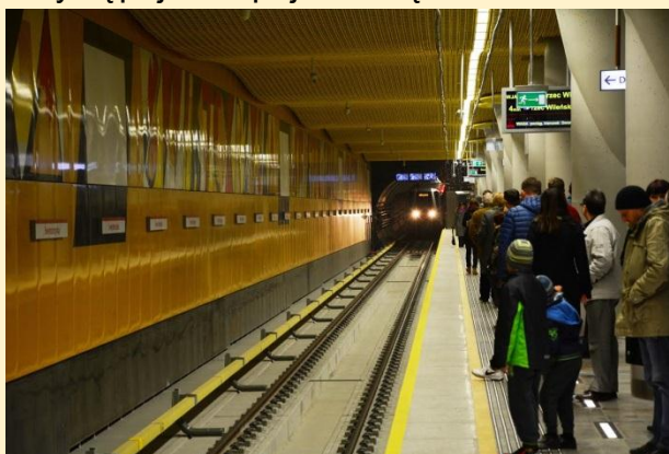
Negatywny przykład umieszczenia przeszkód (podpory stropu) na stacji metra.
